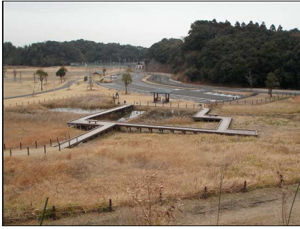
作業前の様子
