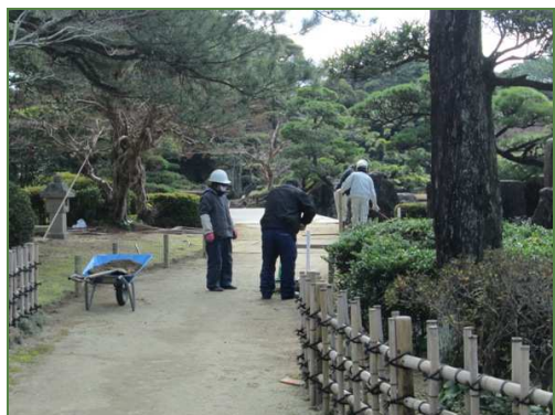
現在工事中です
